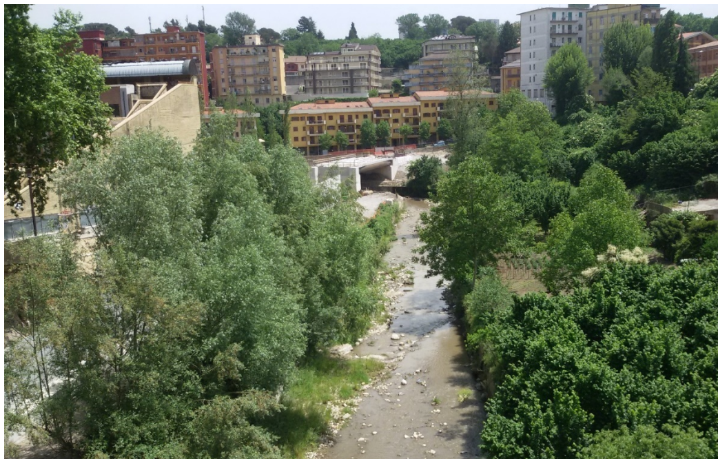
Foto 3 – Tratto urbano del torrente Fenestrelle nel Comune di Avellino
